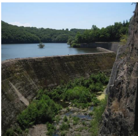
Barrage sur la Tardes
